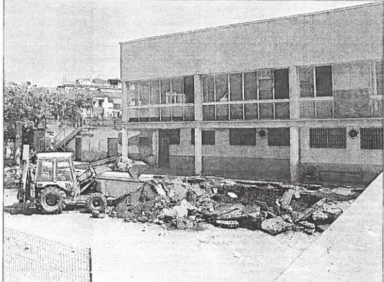
Enderrocament de l'edifici de la SMAP, on s'havien dut a terme nombroses activitats lúdiques i esportives. Els treballs s'hi van començar dijous.
